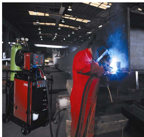
Рис. 38 Сварка МАГ несущих балок в строительстве стальных конструкций
