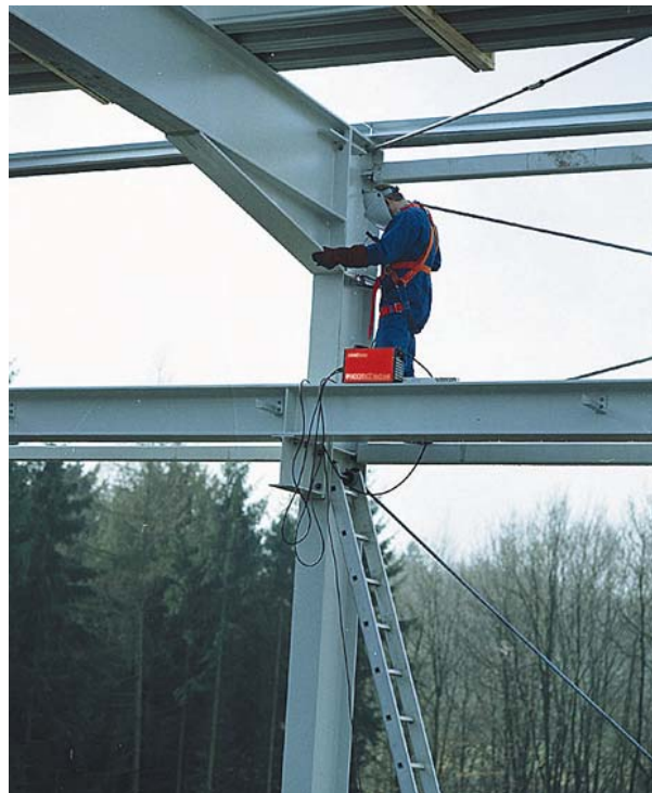
Рис. 20 Применение в качестве источника питания инвертора PICO 140 (4,6 кг/140 А) на строительной площадке
