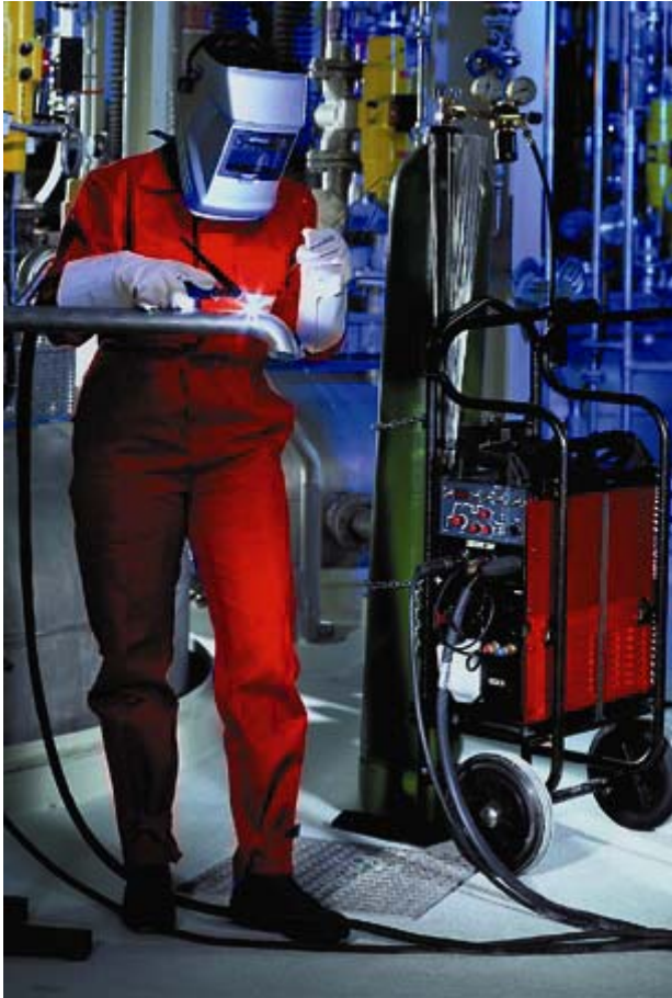
Рис. 6 Сварочные работы ВИГ в химической промышленности
