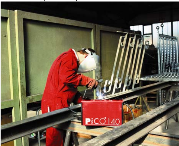
Рис. 22 Применение ручной сварки стержневыми электродами в изготовлении перил
